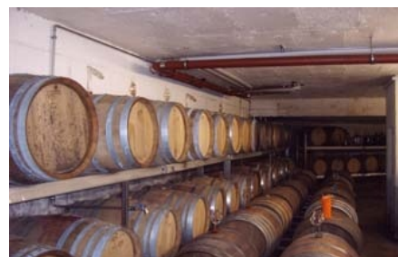
Nachschau 2015 keinerlei Schimmelpilzbefall
